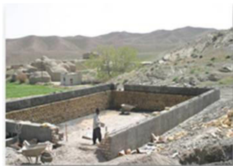
نمایی از ساخت استخر ذخیره آب در آبادی گرماب بالا
